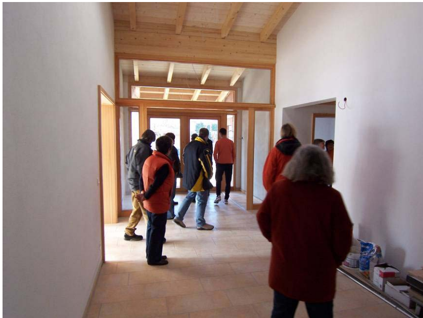
Februar 2007: Die Gemeinderäte besichtigen den Baufortschritt, . . .
