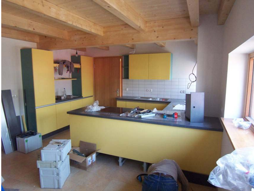
Februar 2007: Die neue Küche wird eingebaut
