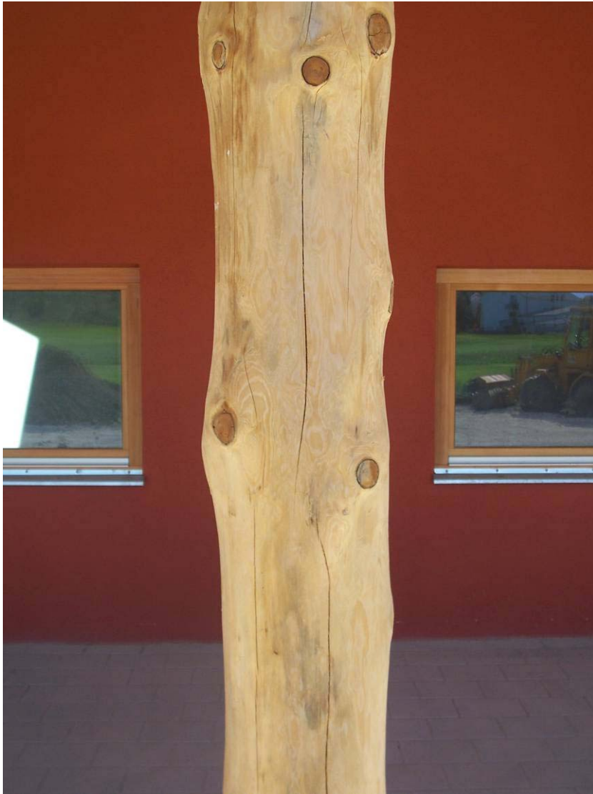
Mai 2008: Baumstütze vor der roten Südwand der Intensivräume
