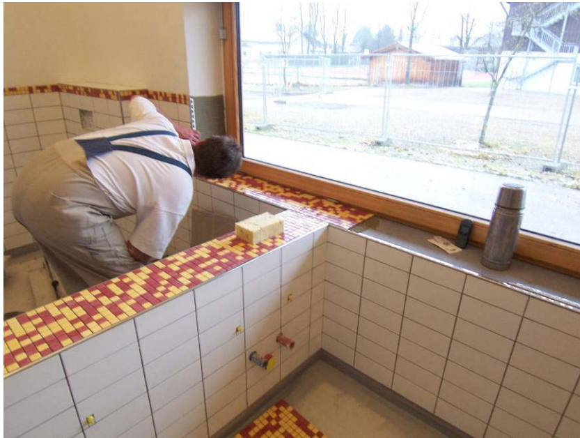
Dezember 2007: Das Aussuchen der richtigen Fliesen hat fast länger gedauert, als das Verlegen !
