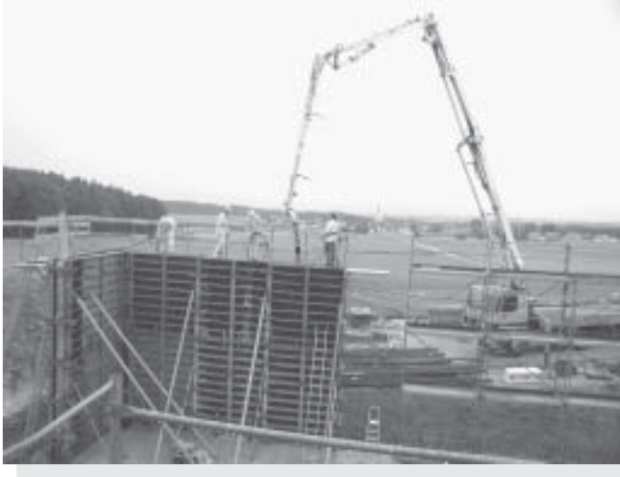
Ein Teil der Seitenwand wird gerade betoniert
